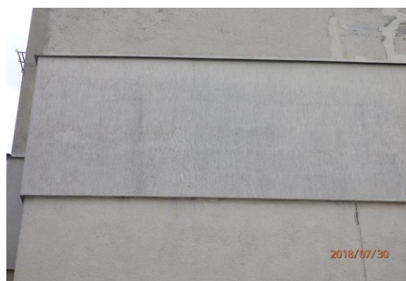
Снимка 6 – Фасадна стена
