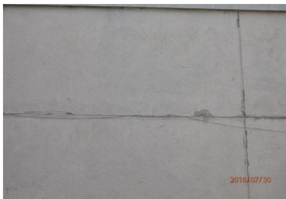
Снимка 5 – Фасадна стена
