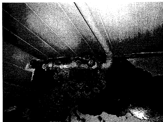
Теч от повреден главен водомерен възел
