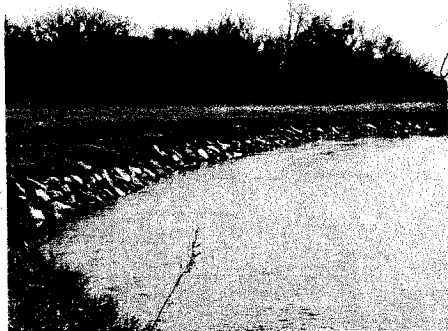
Фиг.1 – Общ вид на укрепване „Riprap“
