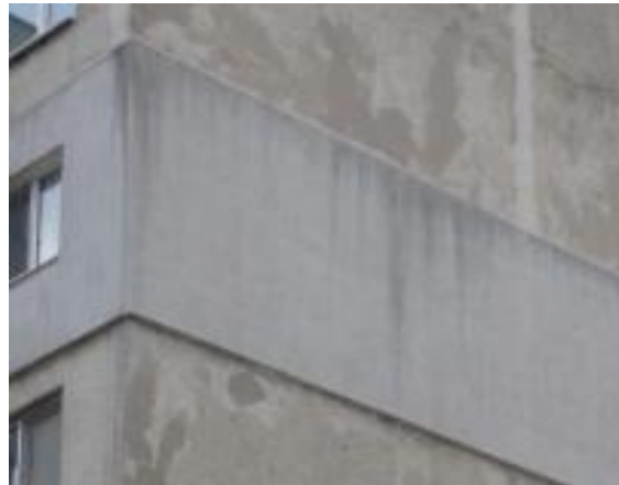
Снимка 6 – Фасадна стена
