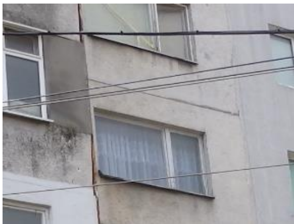
Снимка 5 – Фасадна стена
