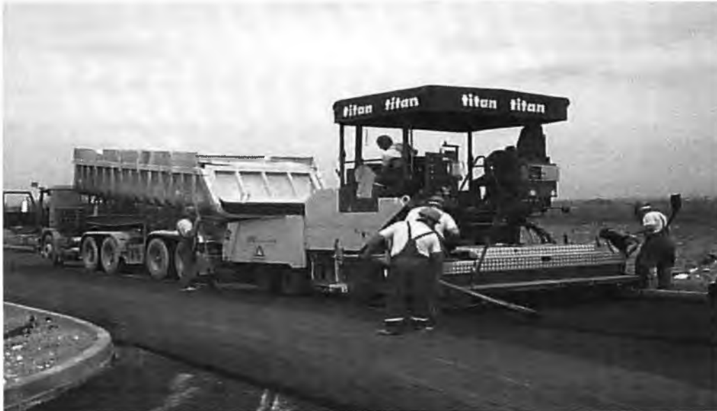
Фиг.3 Полагане на асфалтова смес на половин ширина на пътното платно
