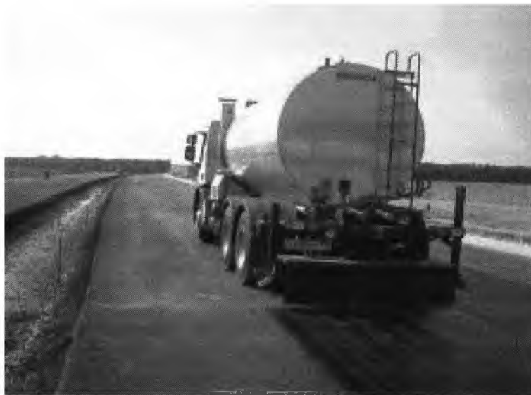
Фиг.2 Полагане разлив на битумна емулсия
