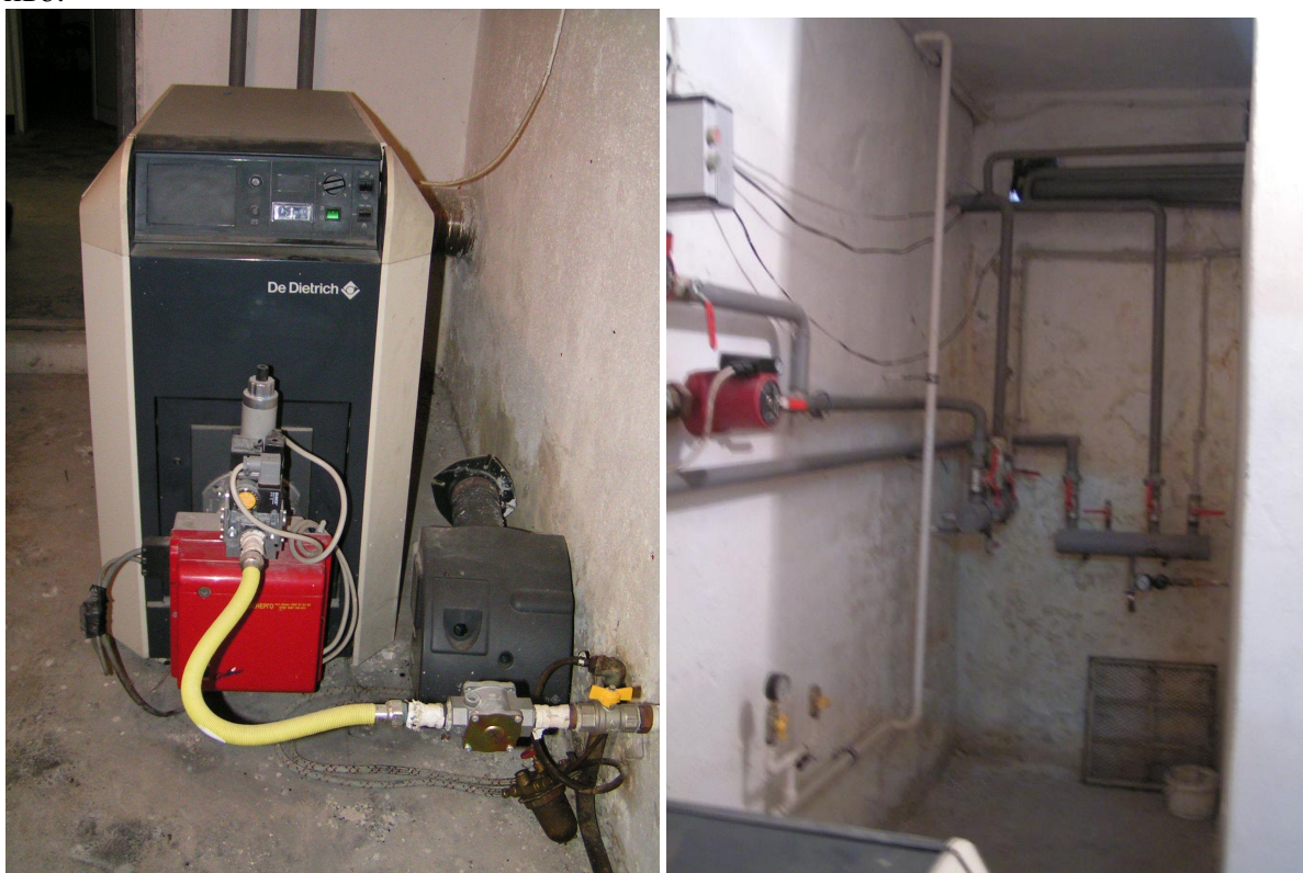
Фиг. 6. Котел и разпределителни колектори.
